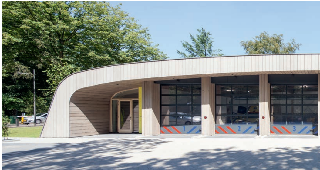
Stalling van buiten. Ieder geveldeel moest apart worden ingemeten, in de lijn van het dak gezaagd en ten slotte genageld.
