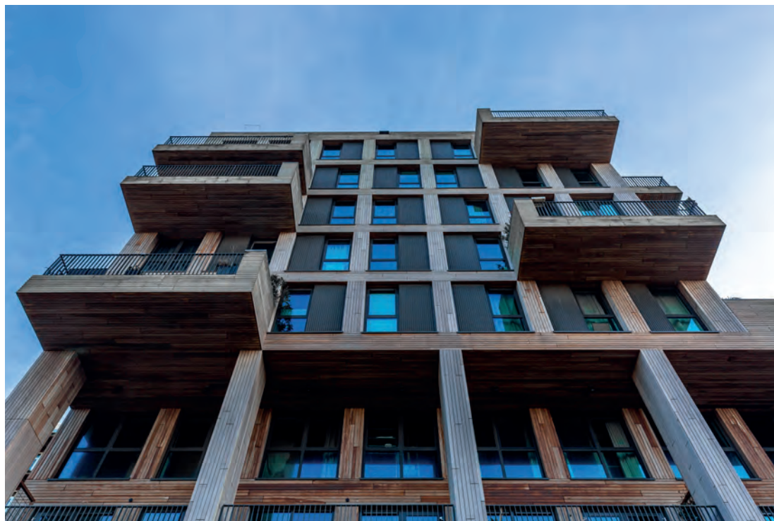
Woongebouw Het Hooghout in Amsterdam (2021) heeft een gevel van thermisch gemodificeerd Fraké, met brandvertraging: Flame Delay van Leegwater en een Sansin Woodsealer.
