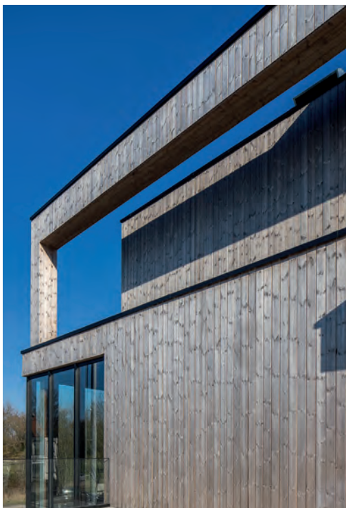
Houten gevelbekleding van de sporthal van Gantoise in Gent (B). Het is ThermoWood grelen van LDCwood, brandvertragend behandeld met Burnblock van Lemahieu Group
