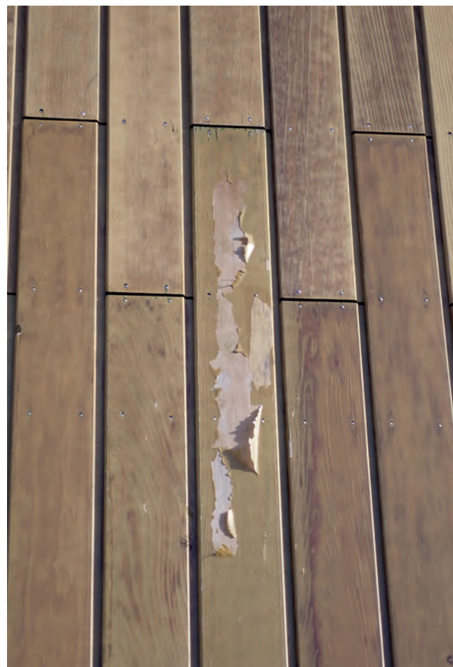
Onthechting van de verflaag op brandwerend behandeld western red cedar door het uitloggen en kristalliseren van zouten.
