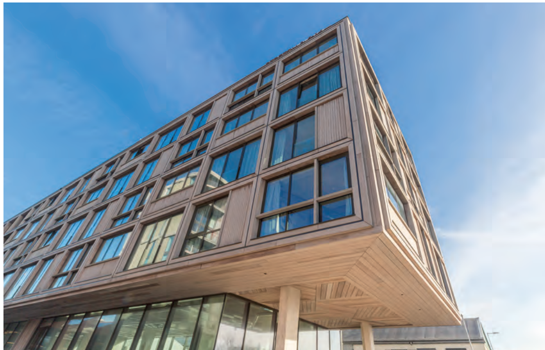
Republica Bob W van MKA Architects in Amsterdam heeft een gevel van thermisch gemodificeerd Fraké (Platowood), behandeld met Flame Delay door Leegwater en de afwerking is een Sansin Woodsealer.
