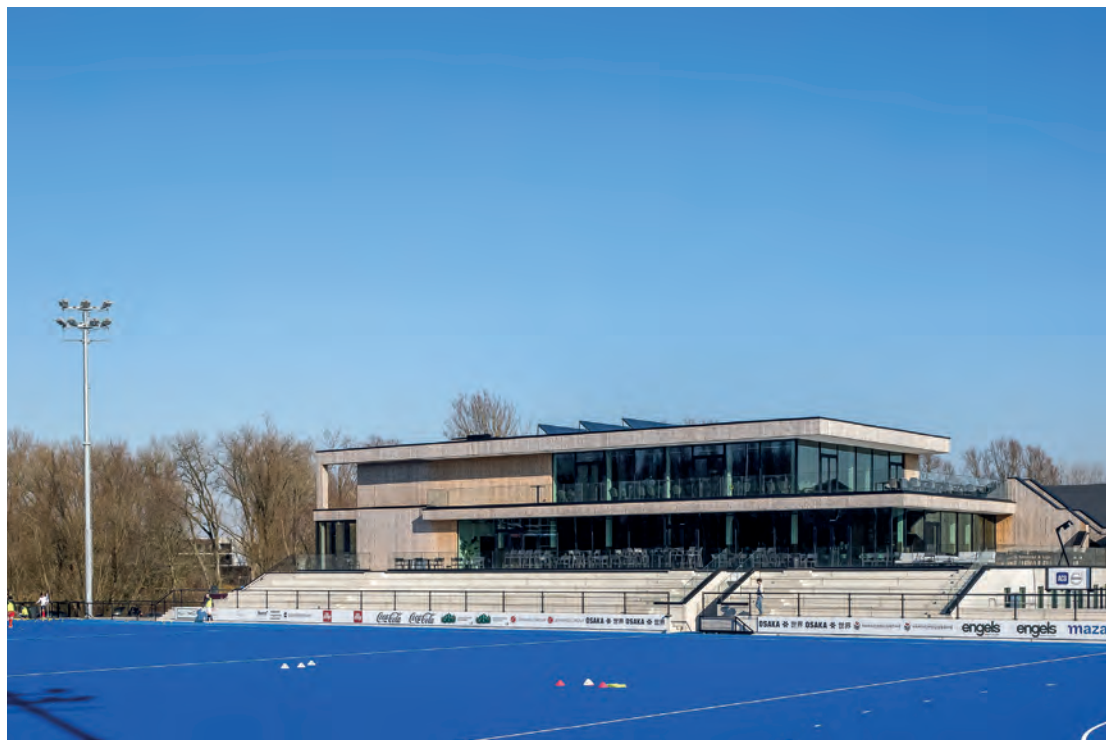
Houten gevelbekleding van de sporthal van Gantoise in Gent (B). Het is ThermoWood grelen van LDCwood, brandvertragend behandeld met Burnblock van Lemahieu Group
